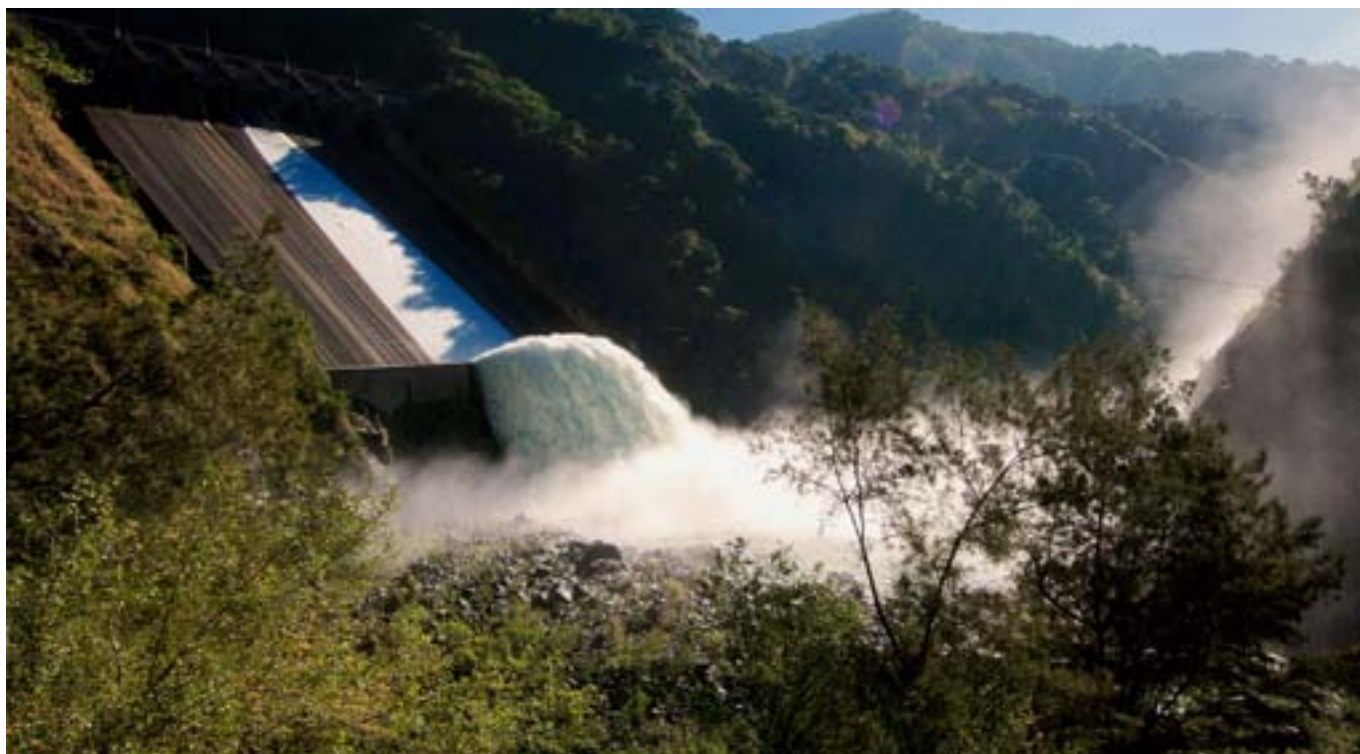
Vannkraftverk, Magat, Filipinene
