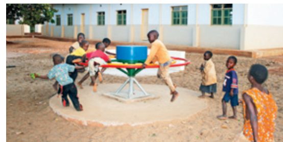
Karusellen foran skolen i forbindelse med Matanuska-prosjektet lekes iherdig med og er samtidig en effektiv brønnpumpe til skolens vann- og kloakksystem.
