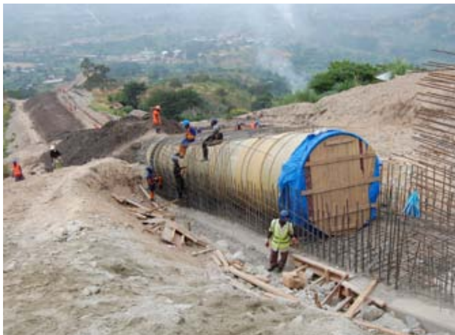
Bygging av vannkraftverket Bugoye, Uganda.
